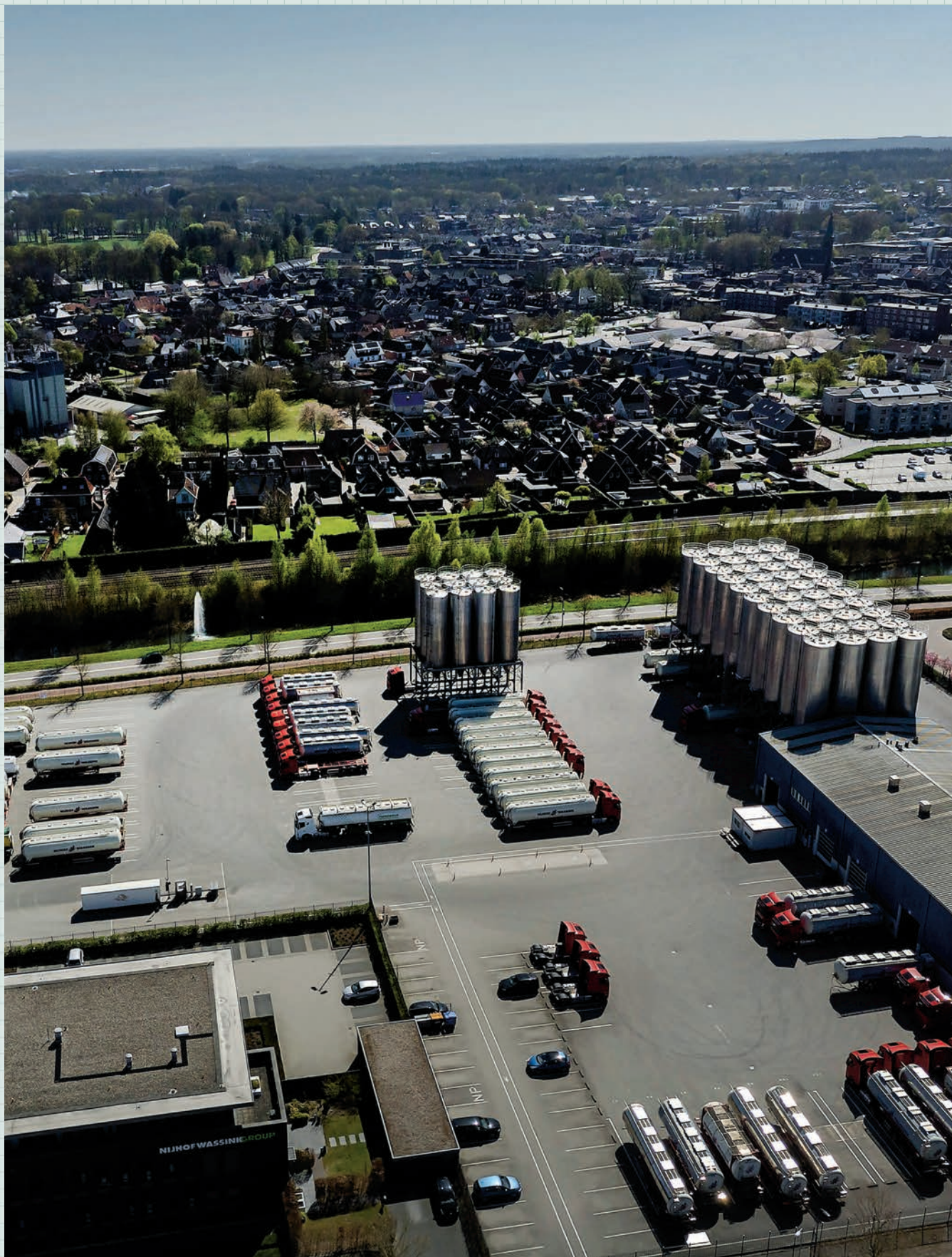
Het bedrijventerrein van logistiek dienstverlener Nijhof-Wassink, op de achtergrond Rijssen
