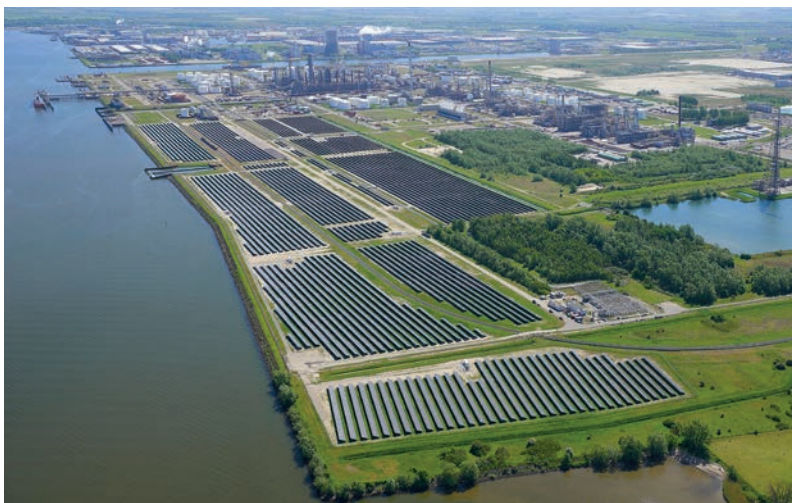
Op het terrein van Shell in Moerdijk staat een van Nederlands grootste zonneparken
